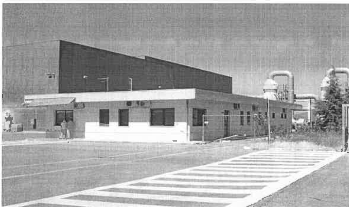
Impianto S.T.I.R. di Casalduni (Bn)
