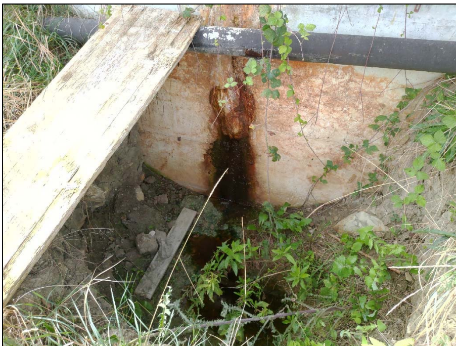
Fig.14: perdita percolato dal muro di contenimento della discarica Consortile
